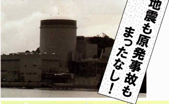
関西電力美浜3号機（福井県美浜町）
