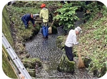
水路の清掃作業
