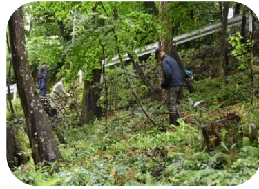
斜面の除草・枝撤去作業
