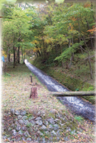
(杉ノ沢直線水路)
