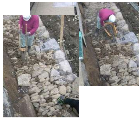
修理状況（転圧と裏込・砕石投入の繰り返し）
