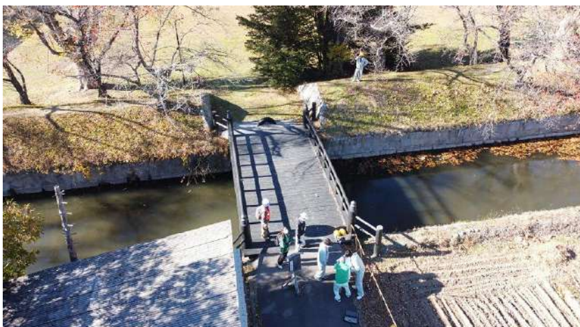
上空から見た作業状況
