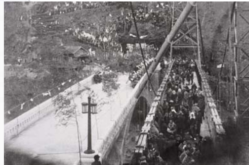
④ 右: コンクリートアーチ桁(現橋)開通式
