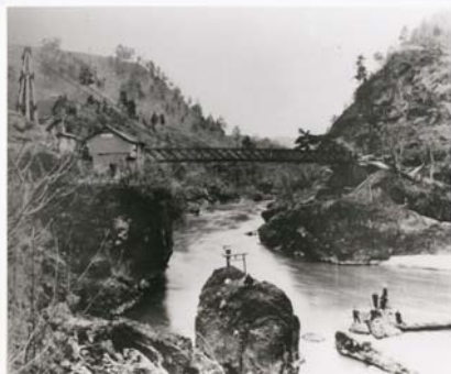
③ 中: 吊り橋
