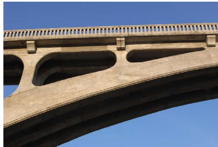
柱上下端側面の大きなR, アーチ下縁のR仕上げ, ブラケット, 高欄
