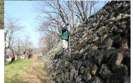
羽毛山（はげやま）地区は、寛保2年（1742）戊の満水で千曲川、鹿曲川で大洪水となり、濁流が村を襲いました。その後も寛政3年（1791）大洪水などが続き、村を守るため、一旦堤防がつくられますが、安政6年（1859）の大洪水により堤防が流失し、大きな被害となります。その復興として文久4年（1864年）に小諸藩の援助により完成した堤防が現在の羽毛山堤防です。**昨年の台風19号の洪水にも耐え、160年の歴史を持つ、石積みできた日本の伝統的な技術に基づく治水施設です。**
