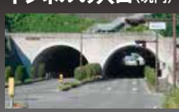
眼鏡トンネル (飯田市上郷トンネル) 上下線分離4車線道路に見られる。
