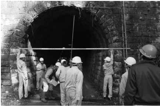
写真8 長野高専による戸草隧道の測量調査(信濃町)
