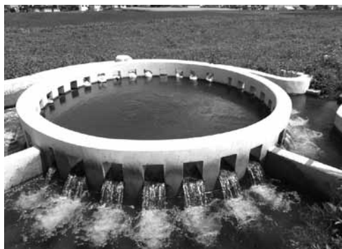
写真7 西天竜用水円筒分水工 (伊那市から辰野町)
