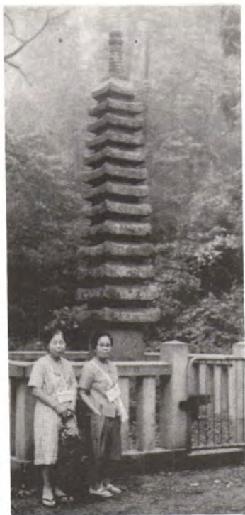
白峰寺 十三重塔東塔
