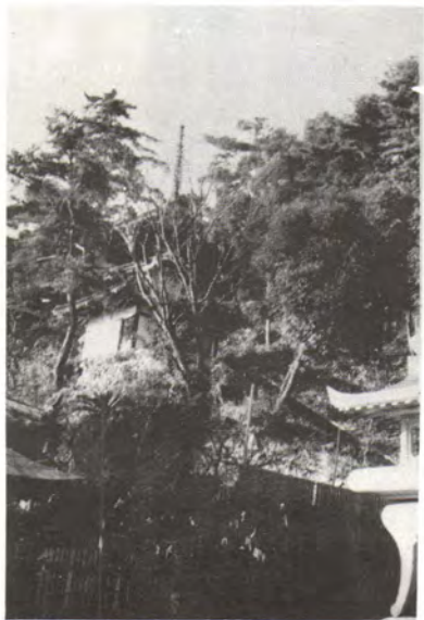
切幡寺 二重塔
