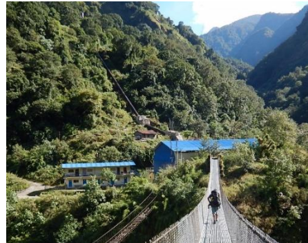
山腹から導水管が発電所建屋へ
