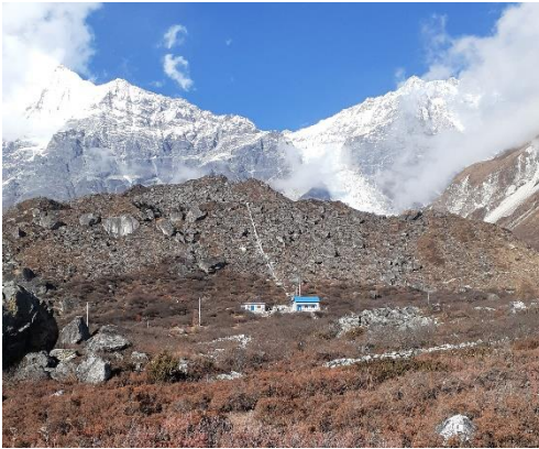
氷河湖からの導水管と発電小屋 ↑
