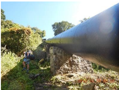
導水管の横の山道を進む
