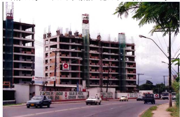
建物の床と柱は鉄筋入り、壁はレンガのみ
