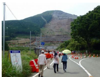
崩落した阿蘇大橋の跡
