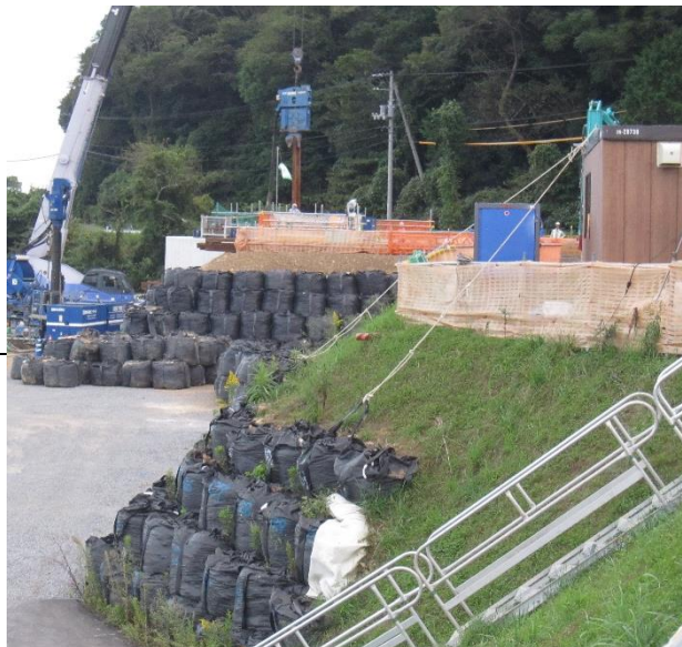
放水路工事現場
