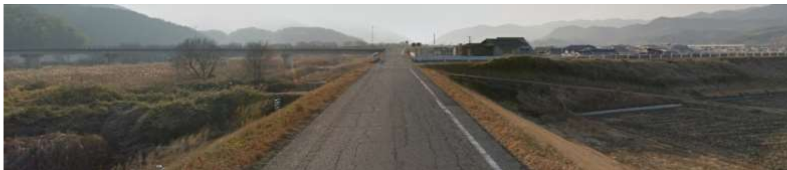
被災前の状況（Googleストリートビューより）
