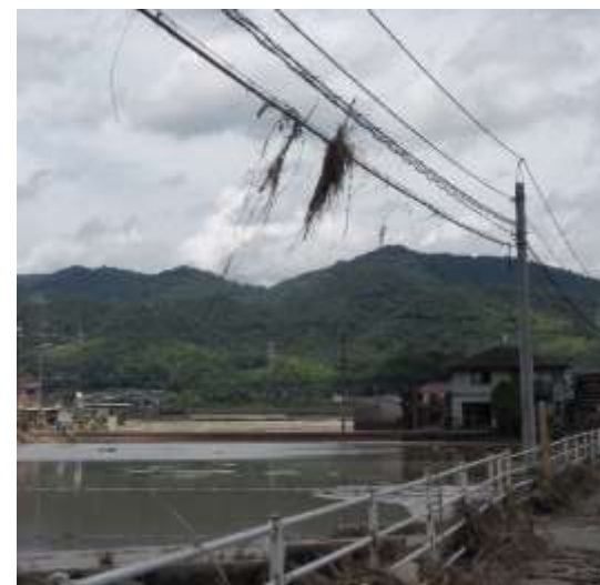
電線には草が引っかかっている。道路面からの高さ約3m
