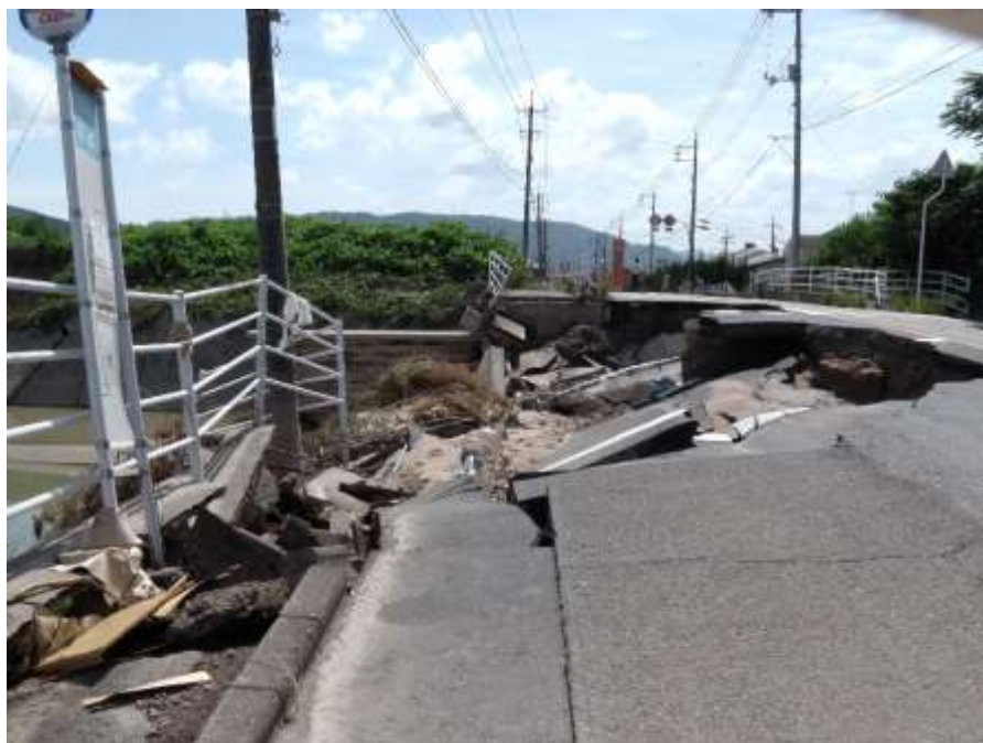
左岸側道路の崩落状況。破堤による水流で浸食されたと考えられる。
