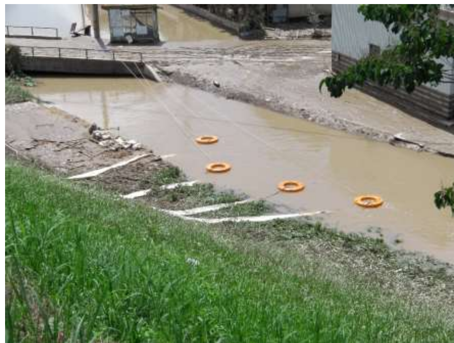
吸水側の状況（写真撮影時は給水が停止している）
