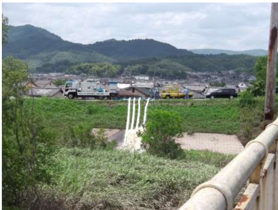
排水側の状況
