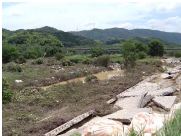
破堤箇所堤外地の状況
