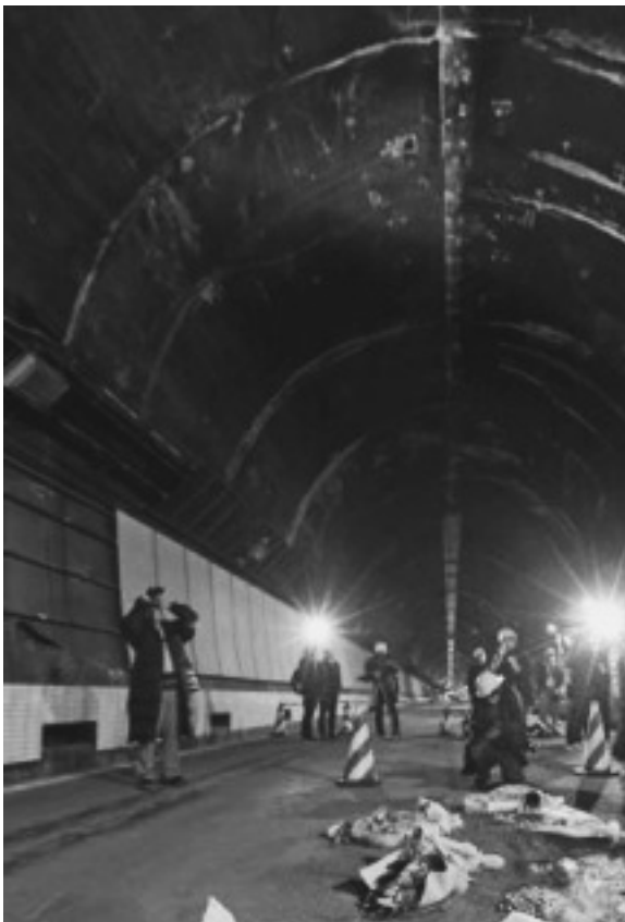
9人が死亡した中央自動車道笹子トンネル（山梨県）の天井板崩落事故で、中日本高速道路は3日、上り線の崩落現場を初めて報道陣に公開した。路面には遺族が数日前に供えた花束が置かれていた（山梨県大月市）（2013年02月03日）【時事通信社】
