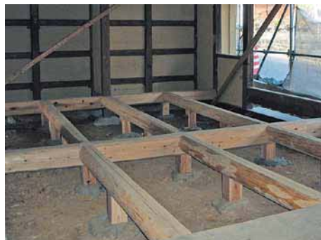
まずは地面の上に石を置いて、柱をささえる土台（どだい）をつくりました。
