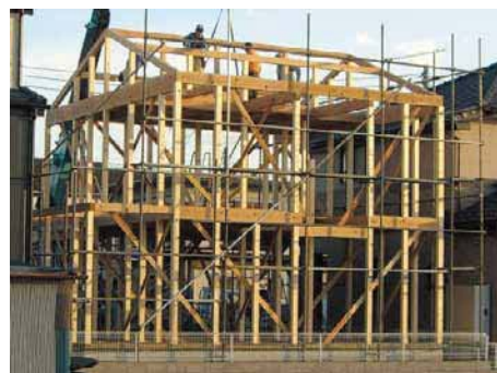
今の家の建設中（けんせつちゅう）のようす。屋根やかべの形が見えてきました。（※写真協力：深澤設計）
