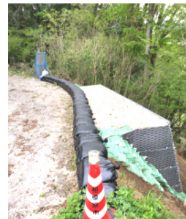
写真①補強された斜面
