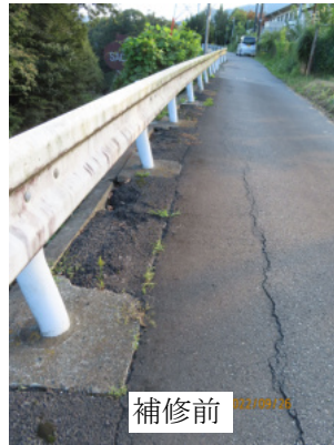
津久井消防署横から町田学園方面に侵入する道路の亀裂
