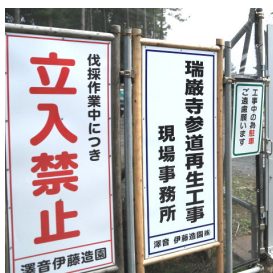
瑞巖寺参道再生工事中の看板
