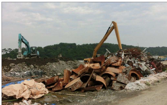
仮棧橋付近瓦礫処理作業中
