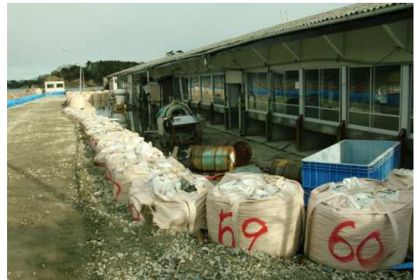
浸水している牡蠣作業場
