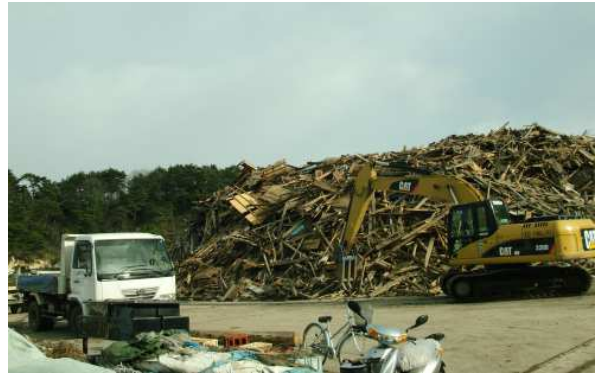
瓦礫の撤去作業中
