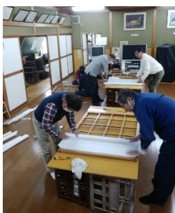
障子張り替えの様子
