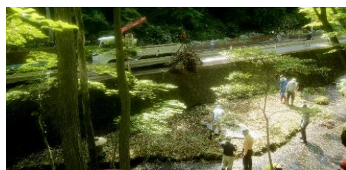
落ち葉や雑草、池の泥をクレーンでトラックへ積み込み
