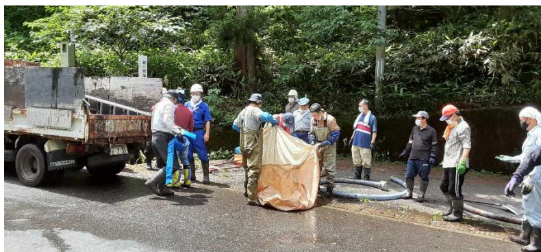
最後の後片付け、これも大変な作業でした。
