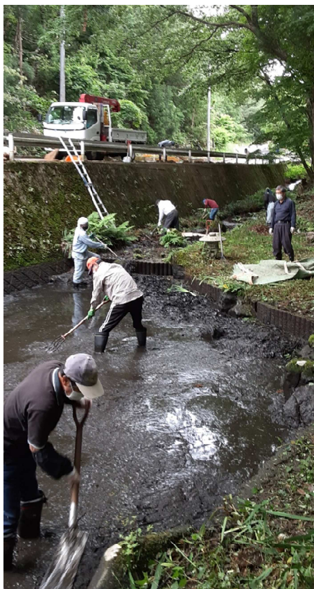
池の底に溜まった泥上げ作業。
