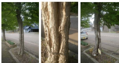
幹の芯が腐って空洞になっている桂の木
