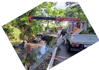
クレーンで泥の吊り上げ作業
